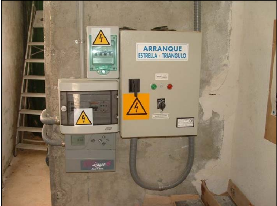
CUADRO ACOMETIDA, MANIOBRA Y CENTRALITA RAIN-BIRD Image 6// MONTAR EN NUEVA UBICACION
