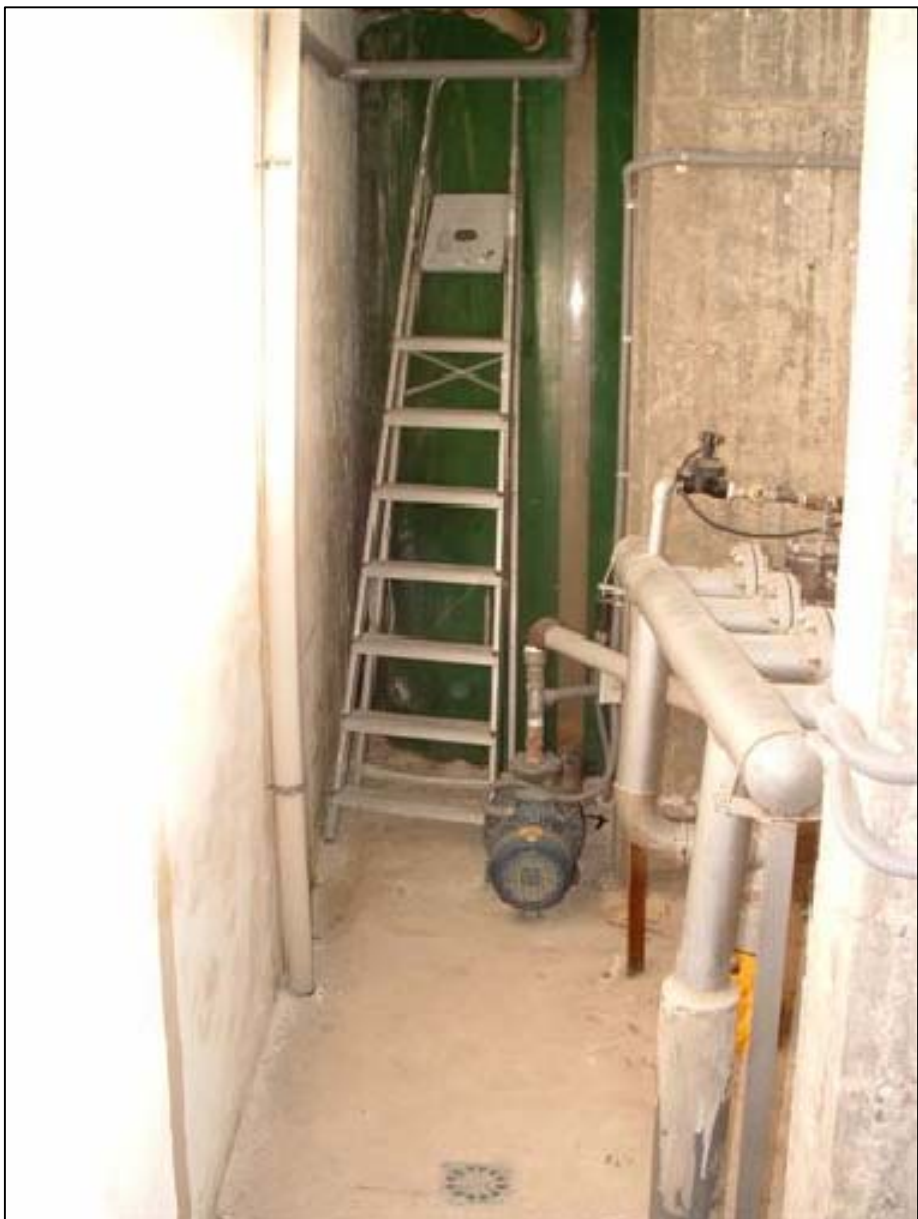
DEPOSITO Y GRUPO DE PRESION// MONTAR EN NUEVA UBICACION
