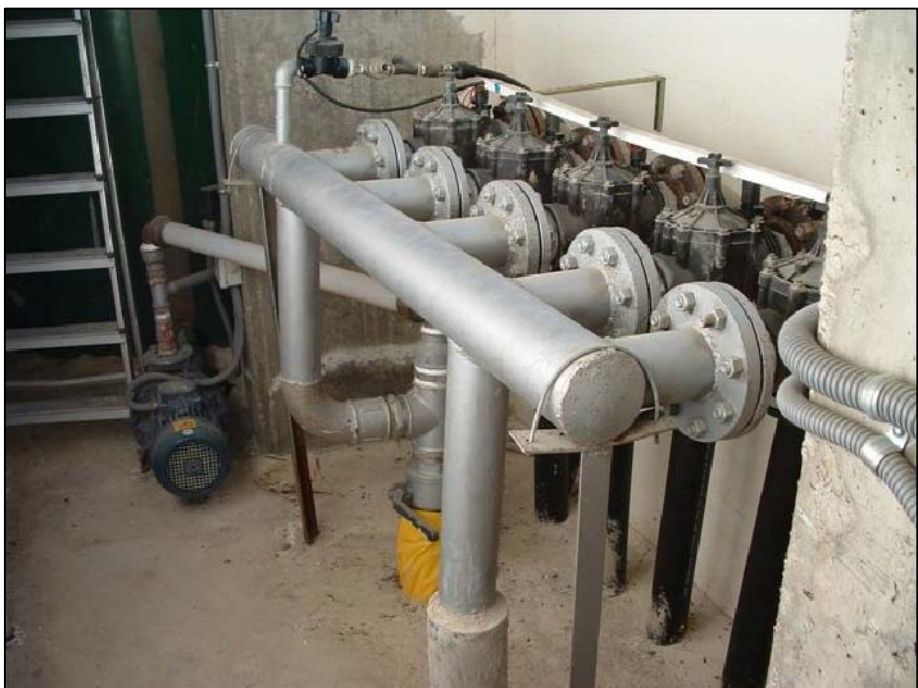
COLECTOR 3 ELECTROVALVULAS Dn.90 + 1 DE GOTEO// MONTAR EN NUEVA UBICACION
